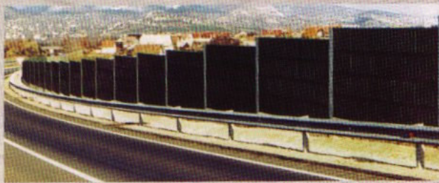
Skaņas izolācijas siena, kas norobežo apdzīvojamo vietu no automaģistrāles.
